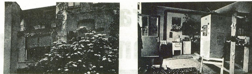
In diesem Zustand fanden wir das Haus im März vor. Jetzt können hier wieder Menschen leben.
